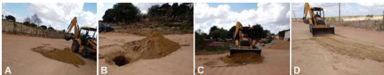
Figura 2.2 – Sequência ilustrativa dos procedimentos de abertura (fotos “A” e “B”) e fechamento (fotos “C” e “D”) das trincheiras.
